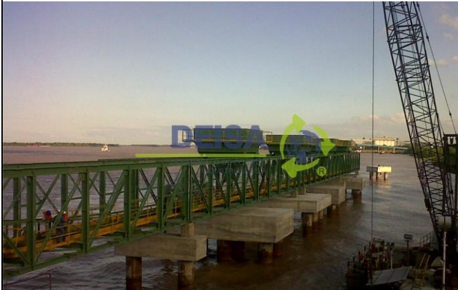
Vista de una instalación de descarga similar a la que prevé Pier Doce, compuesta por una cinta transportadora y tolva móvil, emplazada en el Río Paraná
