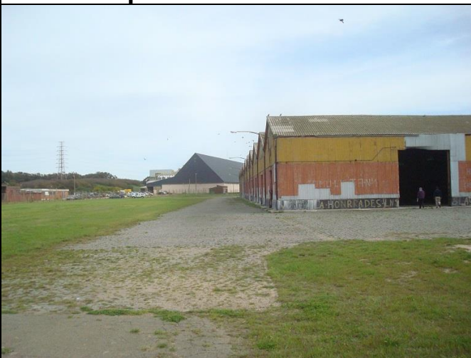
Galpones a Demoler y Adoquinado a Entregar al CGPQQ
