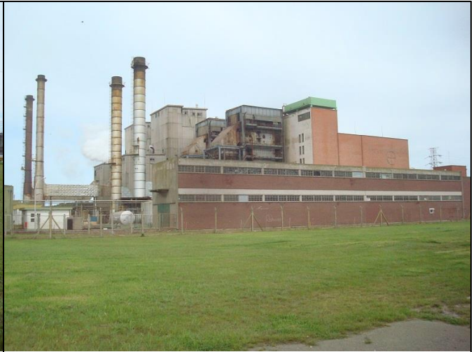
Central Termoeléctrica de la Costa (CTC)
