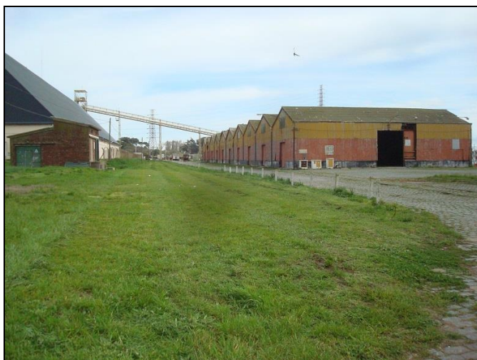
Galpones de Demoler
