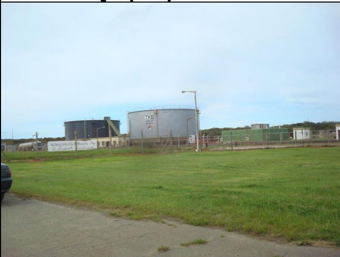
Tanques de Combustible - CTC
