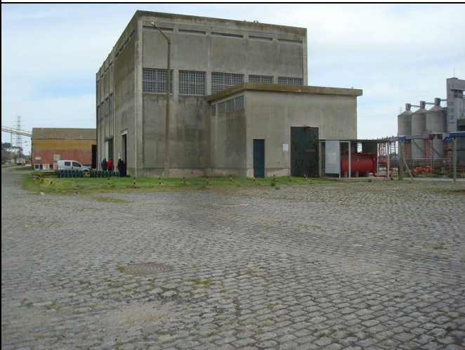
Sala de Bombas Toma de Agua - CTC
